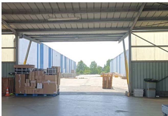
UN ESPACE À COMBLER. Cette photo a été prise avant les travaux qui ont duré plus d'un an. En comblant ce vide, les employés n'ont plus à braver le froid ou la chaleur pour passer d'un dépôt à l'autre. Pas de perte de chauffage. Le nouvel entrepôt a amélioré les performances thermiques.
