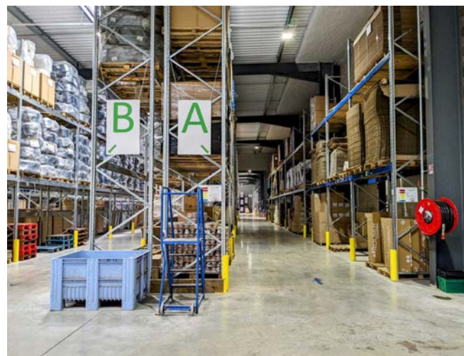
NOUVEAU DÉPÔT. Les travaux ont commencé en 2023 et ont pris fin en janvier 2024. Actuellement, ce nouveau dépôt stocke de la marchandise qui prend de la place : poussettes, séchoirs, tables à repasser, etc.
